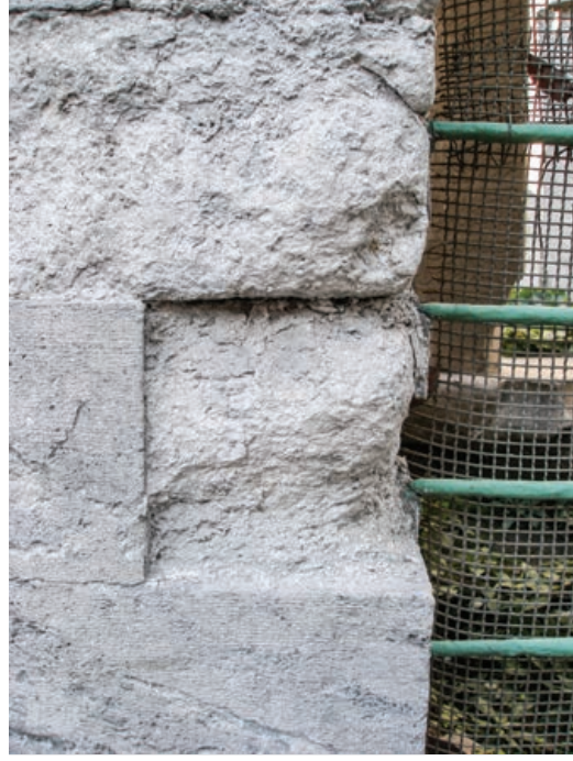
Şekil 8a-b. Beyaz çimento kullanılarak üretilmiş imitasyon malzemenin orijinal küfeki taşında neden olduğu erozyon, genel görünüm ve detay (İstanbul Çorlulu Ali Paşa Medresesi).
