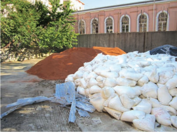
Şekil 4a-b. Horasani harç olarak da adlandırılan, tuğla kırığı ve tozu katkılı kireç harcının hazırlanması ve kubbe yüzeyinde kullanımı (İstanbul Atik Valide Camii Külliyesi).
