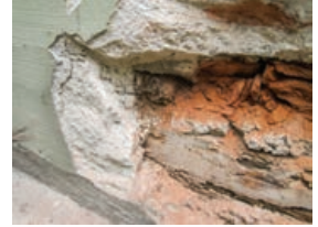
Şekil 1a-b. İstanbul, Fatih ilçesi'nde yer alan Demirhun Camii'nin dış yüzeyinde uygulanmış olan güncel sıva malzemesi ve detayı.
