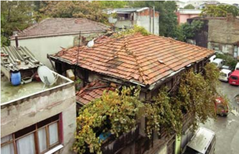
Resim 23. Çatının uygulama öncesi durumu (2006-2007)
