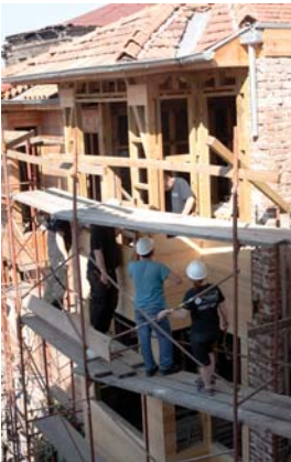
Resim 32. Cephe kaplama levhalarının montajı
