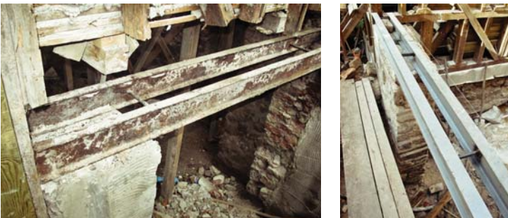
Resim 15. Sökülen demir putrellerin yerine kirişlerin yerleştirilmesi
