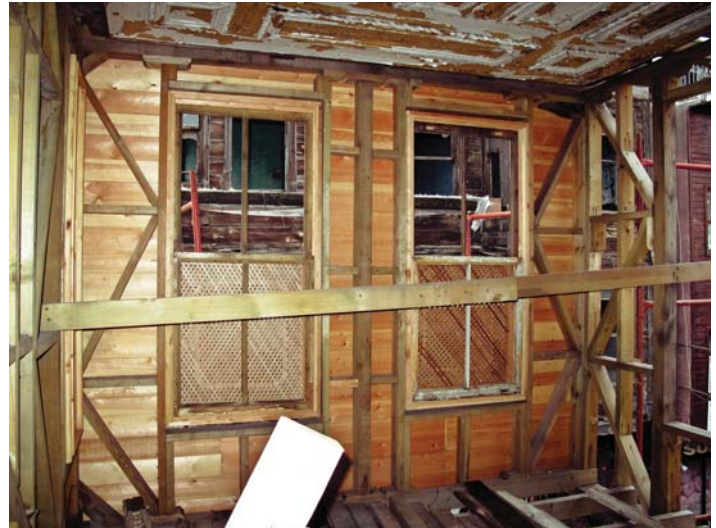
Resim 10. Cephe kaplama levhalarının içeriden görünümü
