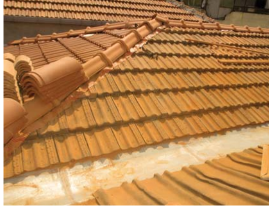
Resim 28. Yapıda kullanılan kiremitler (a: ana yapı, b: II.Dönem yapısı)
