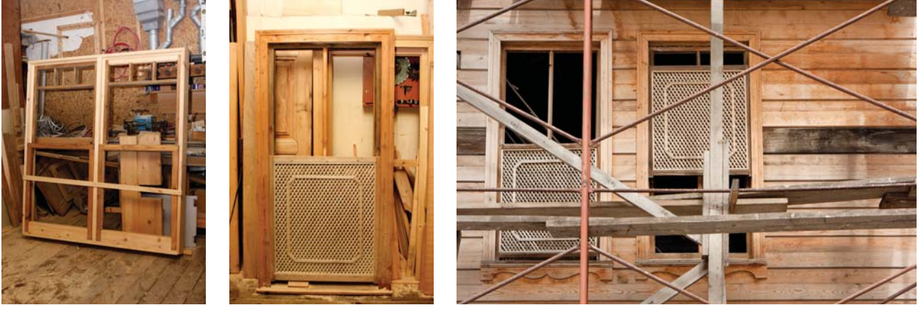
Resim 5. Pencere ve kafeslerin onarım sonrası durumları ve özgün yerlerine takılması
