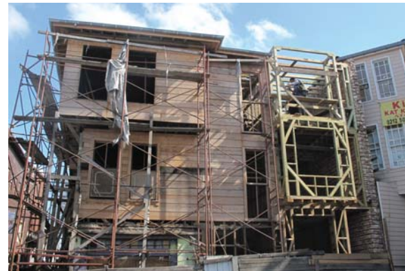
Resim 20. Karkas sistemin yapımı
