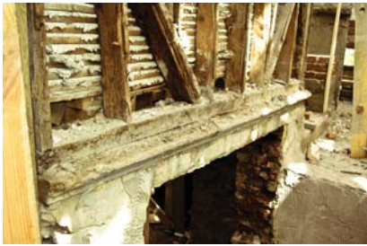
Resim 16. Bağlantı yuvalarının kurşun ile doldurulması
