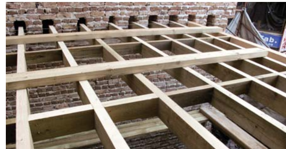
Resim 21. Döşeme kirişlerinin yerleştirilmesi
