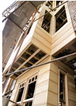
Resim 32. Cephe kaplama levhalarının montajı
