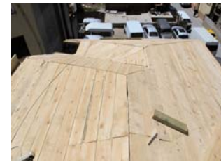
Resim 27. Kiremit altı kaplama tabakalarının uygulanması
