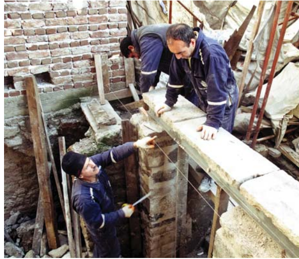
Resim 17. Özgün taş silmenin tekrar yerine yerleştirilmesi
