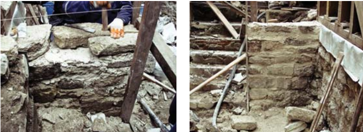
Resim 14. Kaba yonu taş duvarın örülmesi
