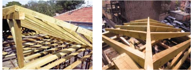
Resim 26. Çatı iskeletinin yapım aşamaları
