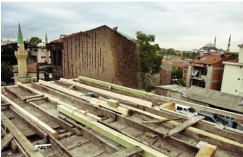
Resim 24. Üst kat tavan kirişlerinin takviyesi
