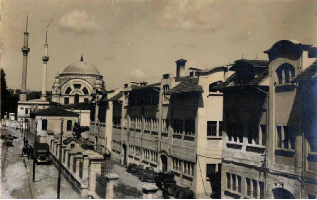
Dolmabahçe (Bezm-i Âlem Valide Sultan) Camii, 1936, Encümen Arşivi
