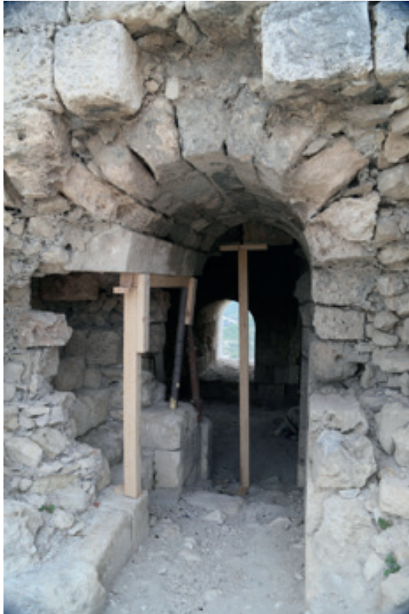
Foto.18- Kazı Sonrası Güçlendirme Yapılan A- 15 Burcu
