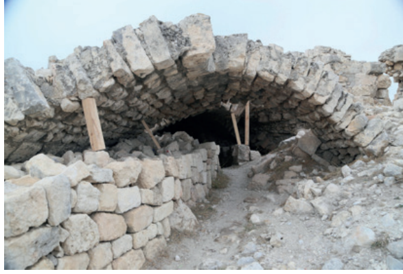
Foto.17- Kazı Sonrası A-7 Mekanının Güçlendirme
