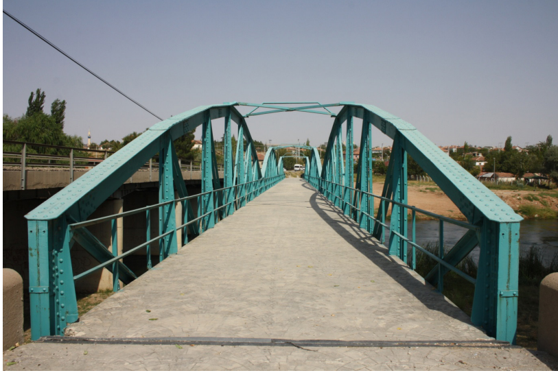
Fotoğraf 7, Yahşihan Köprüsü, Yenilenmiş Tabliye Döşemesi
