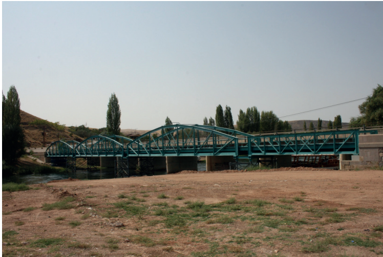
Fotoğraf 3, Yahşihan Köprüsü
