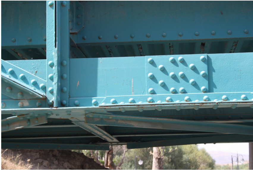
Fotoğraf 9, Yahşihan Demir Köprü, Perçin Detayları
