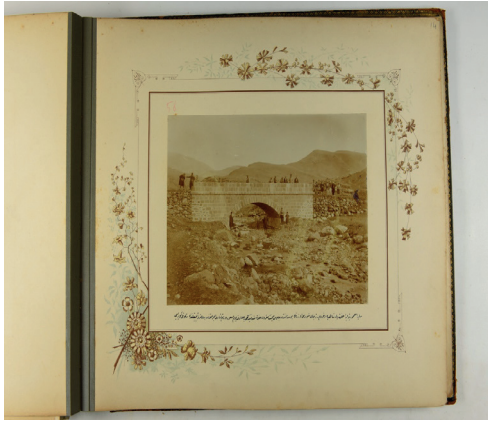
Fotoğraf 5, 1908 Yılında Erzurum'da İnşa Edilmiş Köprü Örneklerinden
