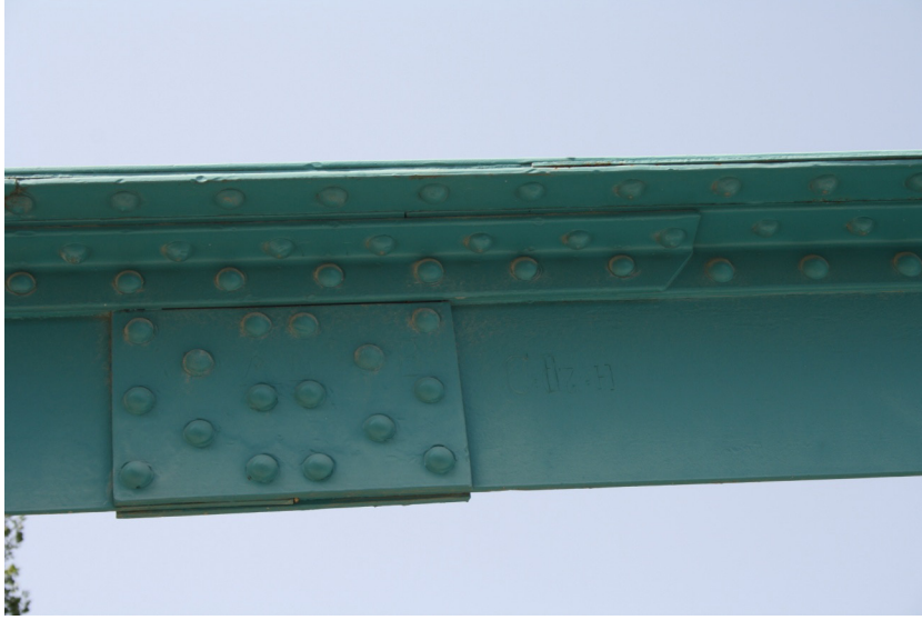
Fotoğraf 8, Yahşihan Köprüsü, Köprü Parçaları Üzerinde Bulunan Numaralandırma Sistemi
