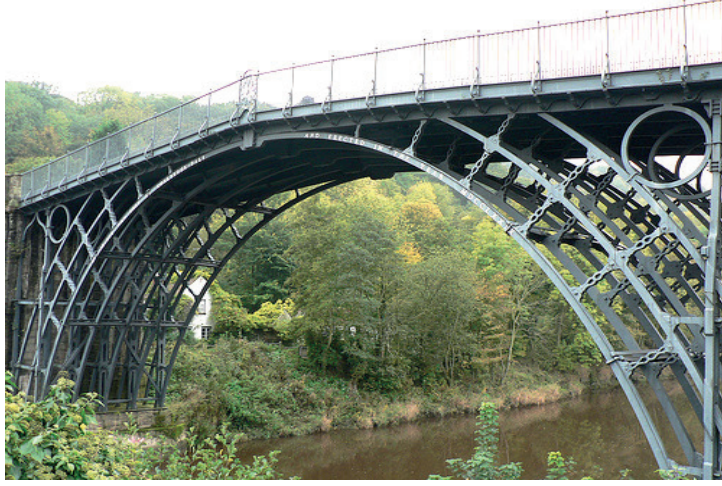
Fotoğraf 1, Endüstri Devriminin Simgesi Olan İngiltere Coalbrookdale'deki Demir Köprü
