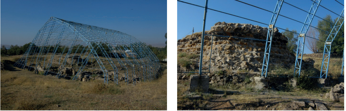
Fotoğraf :5-6 Koruyucu iskeletin ayakları kazı alanı içerisine yerleştirilmiştir. ( Arslan,2017)
