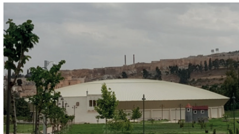
Resim 20. Haleplibahçe Mozaik Müzesi, çatı
