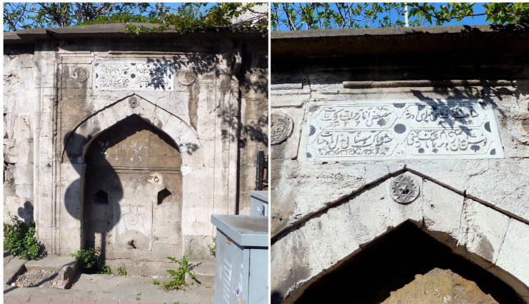
Şekil 4. Mustafa Ağa Meydan Çeşmesi Ön Cephe Görünüşü ve Kitabesi
