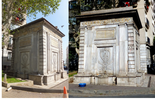
Şekil 14. Bezmi Alem Valide Sultan Çeşmesi Genel Görünüş
