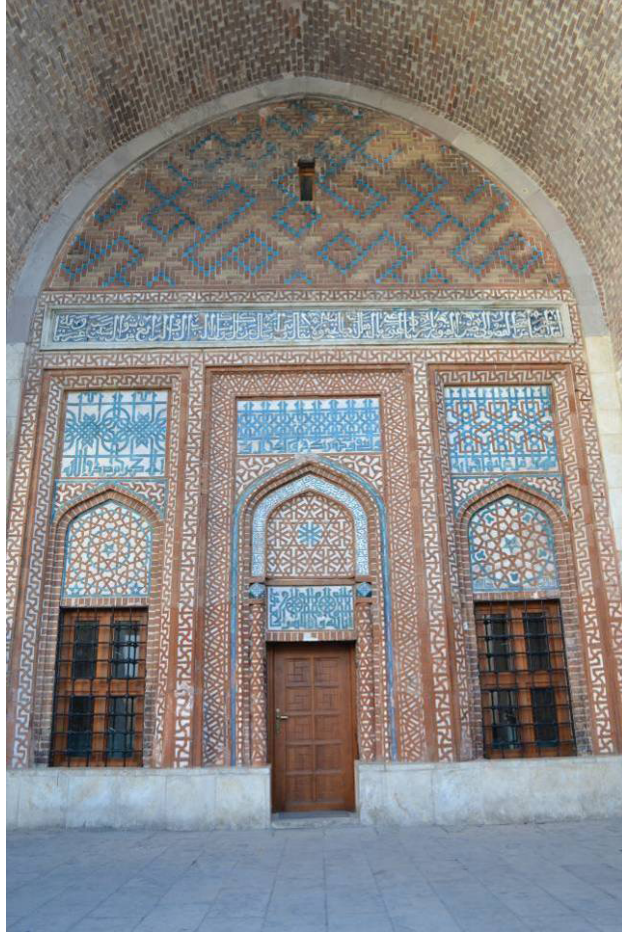
Fot. 1: İzzeddin Keykâvus Türbesi Giriş Cephesi Genel Görünüşü.
