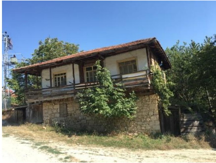
Şekil 16. Zemin kat taş ve üst kat kerpiç
