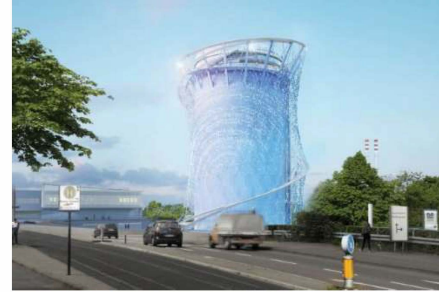
Şekil 36. Enerji Depolama Merkezi (Stadtwerke Heidelberg-Model)
