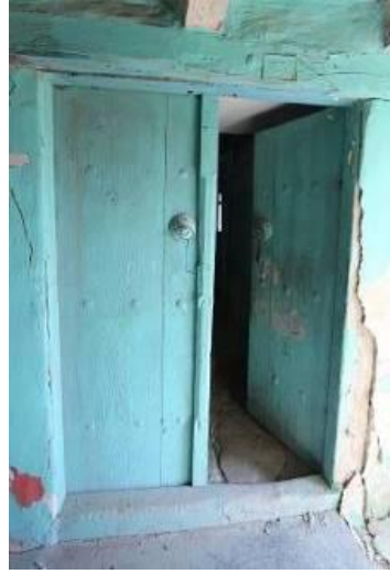
Fotoğraf 9: Giriş mekânı güney duvarındaki harim kapısı
