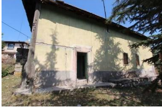
Fotoğraf 2: Batı cephe.
