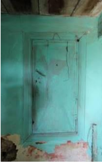
Fotoğraf 8: Giriş mekânının doğu duvarındaki pencere
