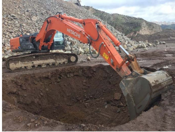
Şekil 7. Ölçümler için sahada yapılan kazı çalışması.
