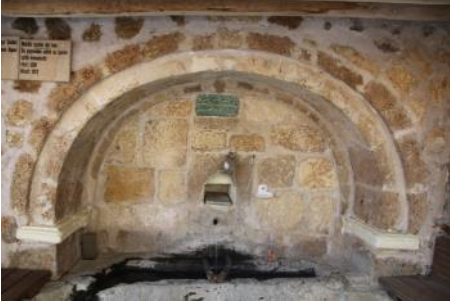
Foto.37. Bekir Ağa Çeşmesi
