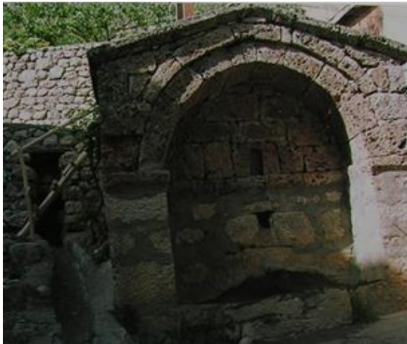
Foto.21. Taşdibi Mahalle Çeşmesi
