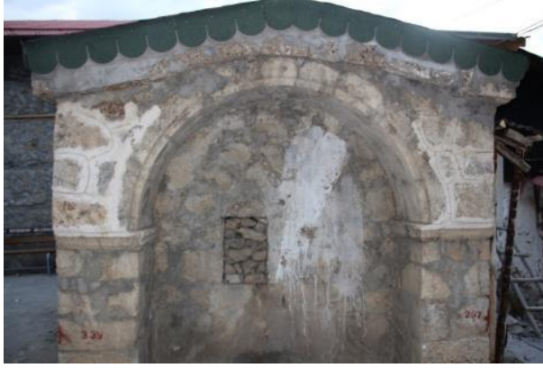
Foto.62. Toybelen Köyü Cami Çeşmesi
