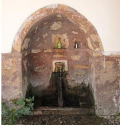
Foto.13: Hacı Şakir Ağa Medrese Çeşmesi
