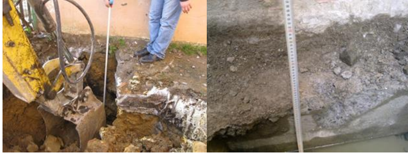
Şekil 2. Binanın dışından ve içinden açılan temel çukurları
