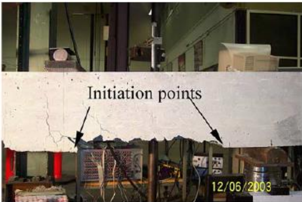
Şekil 14. S3b beton kirişinde CFRP kopma bölgesi
