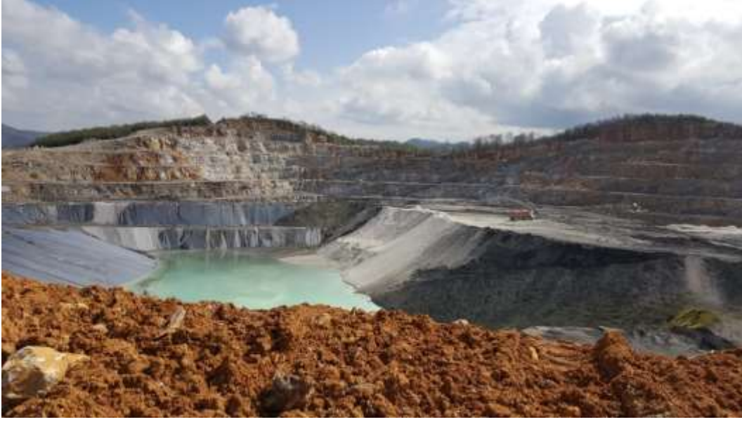
Şekil 4. Zonguldak Eren Enerji A.Ş taş ocağı kül barajı.
