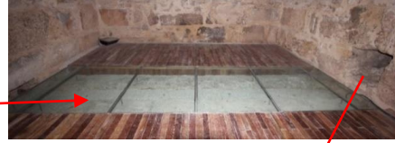
Fotoğraf 8: Cam ile kapatılan kanal
