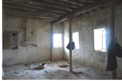
Foto-4: Zemin Kat, Sofanın güneydoğusunda yer alan oda
