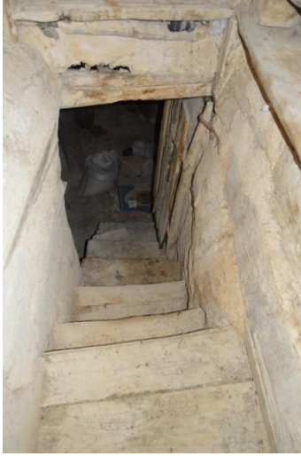
Foto-9: Zemin kat ile bodrum katı birbirine bağlayan merdiven
