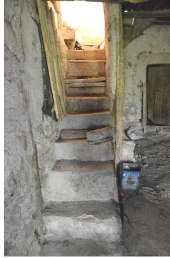
Foto-10: Bodrum kattan zemin kata açılan merdiven
