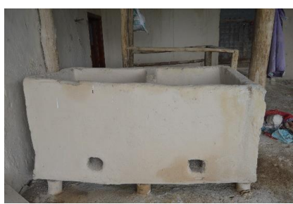
Foto-17: Ahşap çatki kerpiç dolgulu ambar ön yüzü
