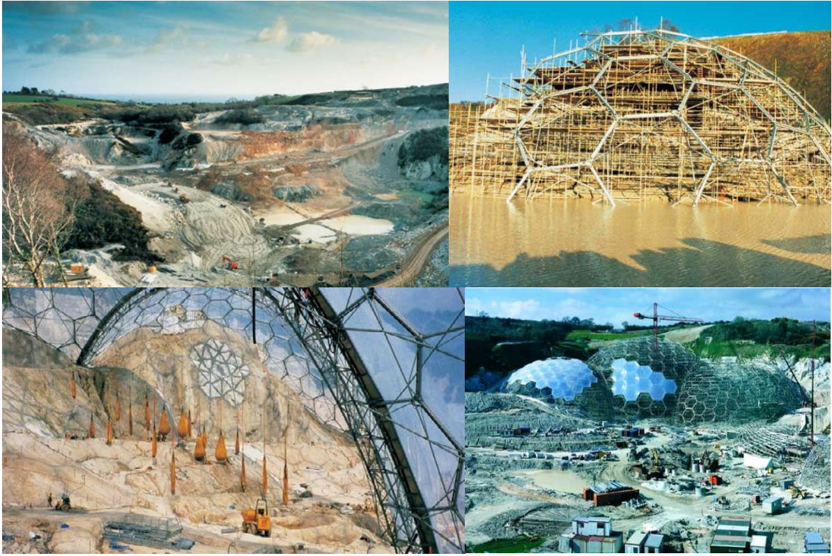
Şekil 1. Eden Project yapım aşamaları [45-46-47]
