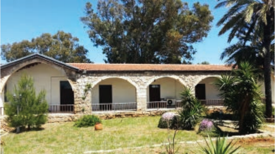
Resim 6. Doğu kanadın avluya bakan revaklı cephesi (M. Eyyamoğlu).
