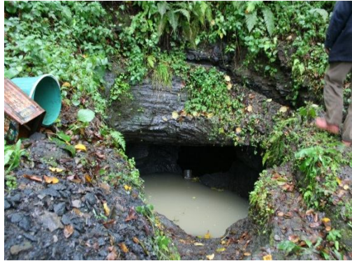
Fotoğraf 4: Yeni ocak girişi, eski girişin birkaç metre solunda ve giriş tabanında toplanan yağmur suyu.
