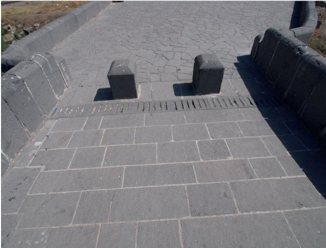
Foto. 4: Muş Ulu Köprü tabliye ve korkuluk görünüşü (V. G. M. Arşivi'nden)
