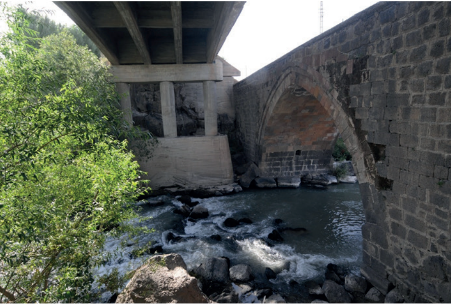
Foto. 7: Malazgirt (Hatun) Köprüsü memba görünüşü
