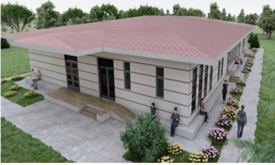
Şekil 16. Binanın güney doğu görünüşü
