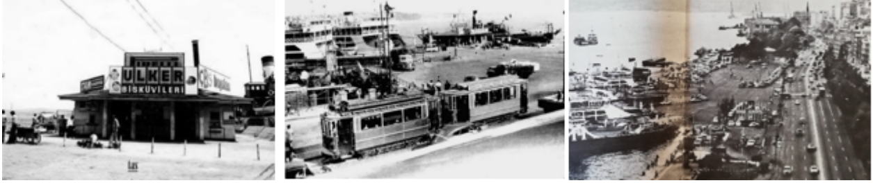
Şekil 8. 8a; 20. yüzyıl ortalarında inşa edilmiş betonarme Kabataş arabalı vapur iskelesi (Url-8), 8b; Setüstü'nden bakış (Url-2), 8c; 1973 tarihli Kabataş ve Setüstü fotoğrafı (Gülersoy, 1973)
