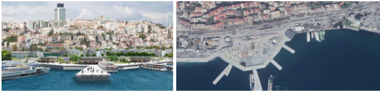
Şekil 13. 13a; Kabataş iskelesi meydan düzenlemesi ve transfer merkezi proje görseli (Url 12), 13b; 2019 hava fotoğrafı
