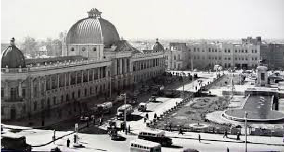
Resim 15. Telgraf Binası, Tahran (1928)
