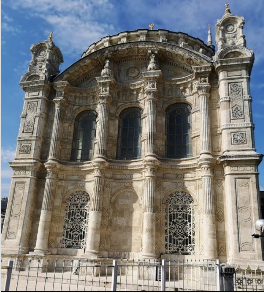
Şekil 5. Büyük Mecidiye Camisi Güney /Kible Cephesi (Akıldız, 2019)
