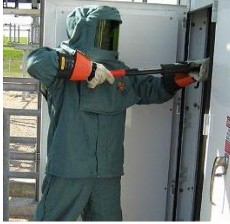
Şekil 2. Çalışan Personelin Uygun Çalışma Mesafesinde Doğru Ekipman ile Müdahale Örneği [10]
