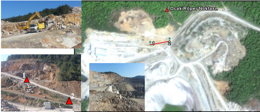
Şekil 11. İşletme Őevi üzerindeki nivelman yolu ve işletmeden görüntüler
