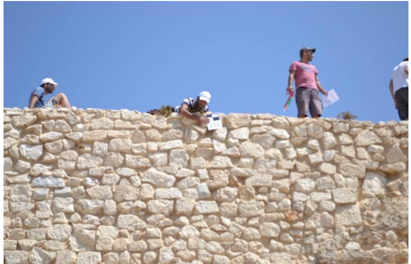
Şekil 7. Kağıt hedeflerin duvarlara yapıştırılması
