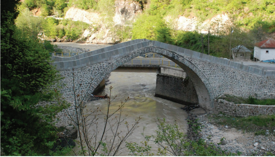
Fot. 2: Ağa köprüsü. Yağlıdere, Giresun. (TKVKBK, 2017)
