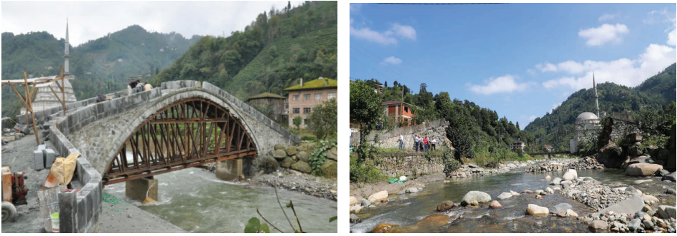
Fot. 4a - 4b: 2011 yılında restorasyonu yapılan ve 2019 yılında yıkılan Rize Ambarlı Köprüsü. (Türkiye Kültür Portalı, 2018) (Hürriyet, 2019)
