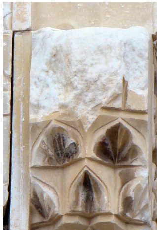
Fot. 7: Aksaray Sultan Hanı, avlu taç kapısı mukarnaşlı konsol
