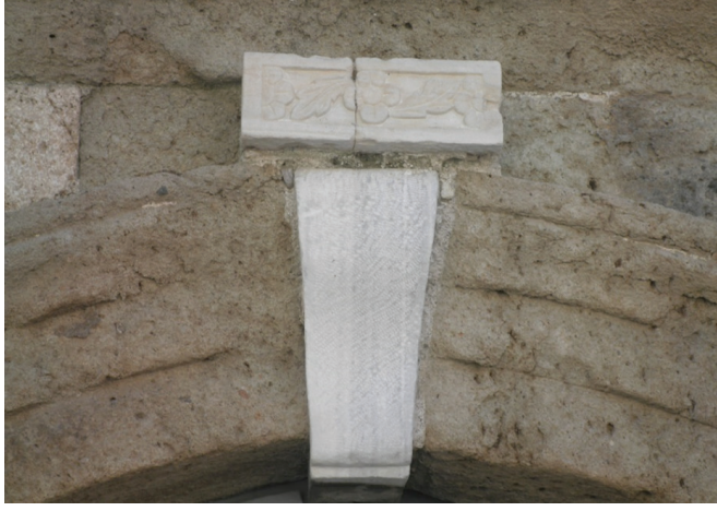
Fot. 4: Mudanya Ayios Yeoryios Kilisesi Ana Giriş Kapı Kemerli Üzerindeki Devşirme Mermer Bezeme Levhası
