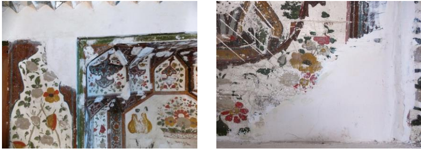
Resim 9. Sıva onarımı. Restorasyon aşaması
