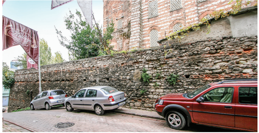
Şekil 15. Çevre duvarı (Fotograf: İ. Sağdıç)
