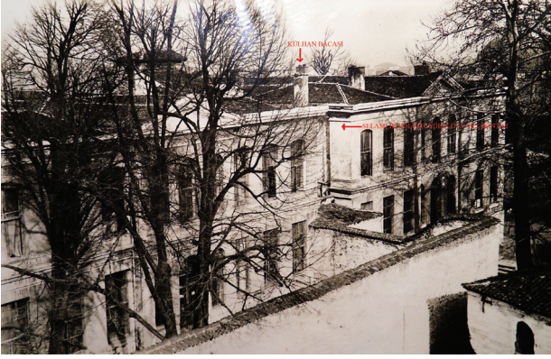
Şekil 107. Ethem Paşa Konağı giriş cephesine bakış (Tüten ailesi arşivi, 1926-1937)
