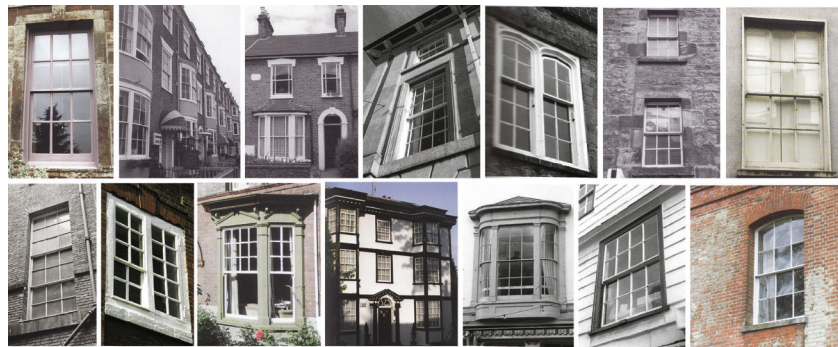
Şekil 99. İngiltere'de 18-19. yüzyıllarda görülen Yunan mimarisi tarzı sürme pencere tiplerinden örnekler (Tutton ve Hurst, 2007)
