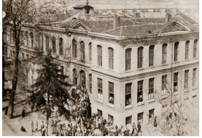
Şekil 27. Ethem Paşa Konağı selamlık avlusu; giriş cephesi ve doğu cephesine bir bakış (Tüten ailesi arşivi, 1926-1937)
