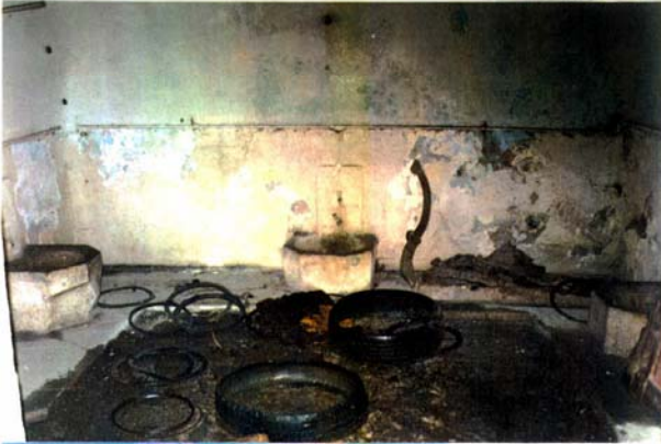
Sıcaklık bölümünde kurna taşları ve bugünkü hâli
