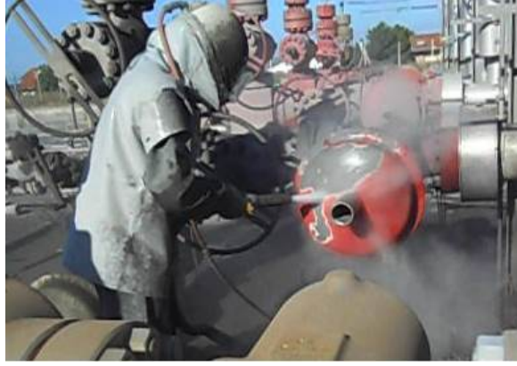
Şekil 1. Boyama öncesi kuşlama işlemleri (Figure 1. Sand blasting operation before painting)
