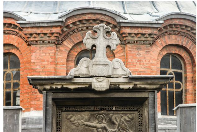
Sekil 31. Mermer bezeme ögesinde görülen sekerci aşınma (Kuzeybatı cephesi)
