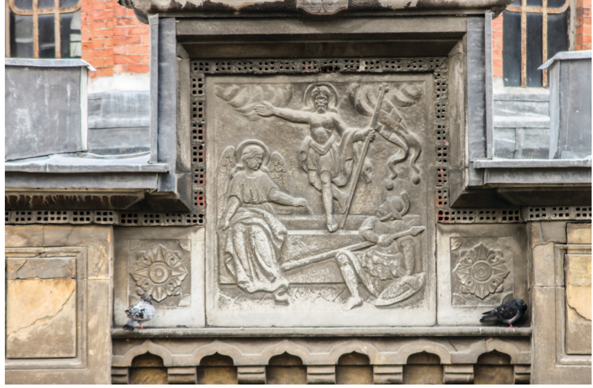
Şekil 32. Mermer ikonada kabuk oluşumu (Kuzeybatı cephesi)
