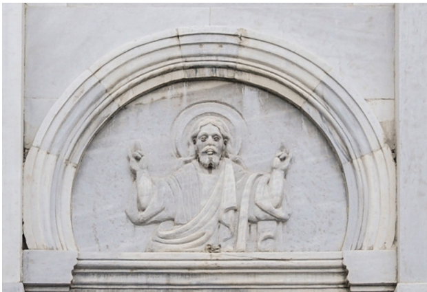
Sekil 30. Mermer kemer aynalarında sekerci aşınma (Güneybatı cephesi)
