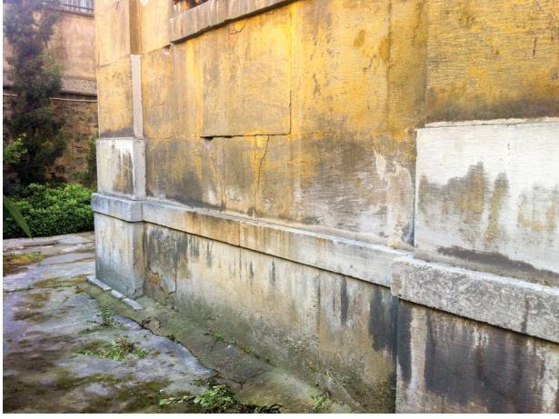
Şekil 19. Cephelerin açık bej veya sarı renkli biyomikritik / mikritik / killi biyomikritik veya kumlu biyomikritik kireçtaşı bölümlerinde görülen kirlenme ve kabuk oluşumu (Kuzeybatı cephesi)
