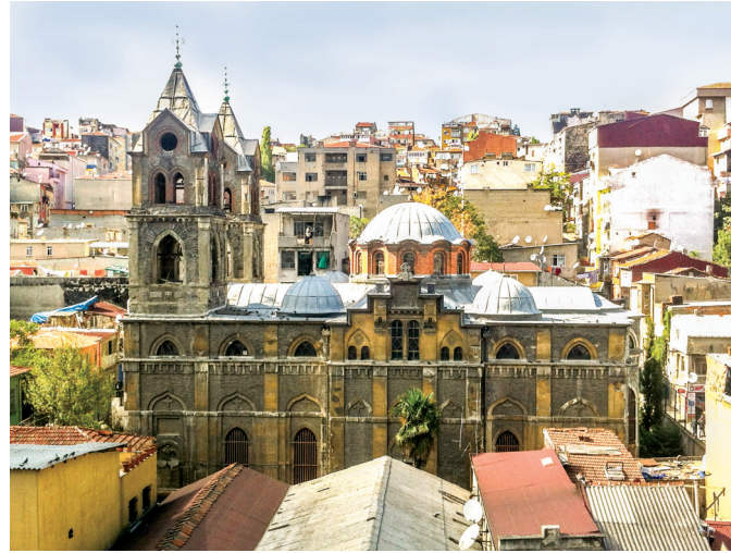
Şekil 11. Evangelistria Kilisesi'nin Dolapdere Caddesi'ne bakan güneydoğu cephesi (Fotograf: E. Aşık)
