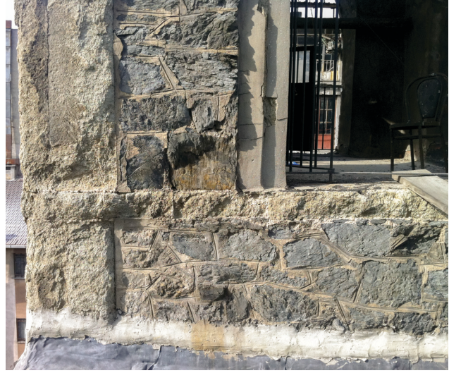
Şekil 20. Moloz taş duvar örgüsünde kullanılan kuvars vake (Batı çan kulesi-grovak)
