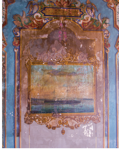
Şekil 13. 104 no'lu odanın D2 cephesi Pano 4
