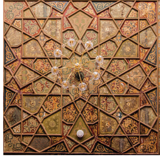
Şekil 17. 108 no.lu odanın tavanındaki Selçuklu geçmesinin konservasyon ve restorasyon öncesi genel görünümü
