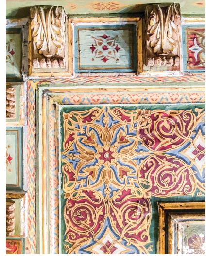
Şekil 45. 108 no.lu odanın tavanının konservasyon ve restorasyon sonrası görünümü/detay
