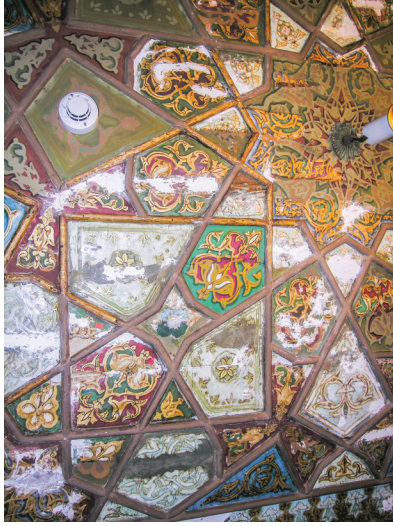
Şekil 43. 108 no.lu odanın konservasyon uygulaması/detay
