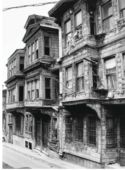
Şekil 1. Kayserili Ahmet Paşa Konağı, 1978. (Fotoğraf: Kurul Arşivi)
