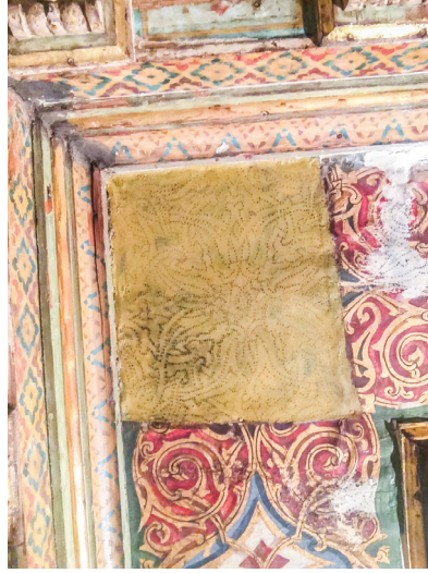
Şekil 44. 108 no.lu odanın restorasyon uygulaması/detay
