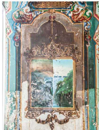
Şekil 33. 102 no.lu odanın tavan ve duvarlarının konservasyon ve restorasyon uygulaması sonrası görünümü
