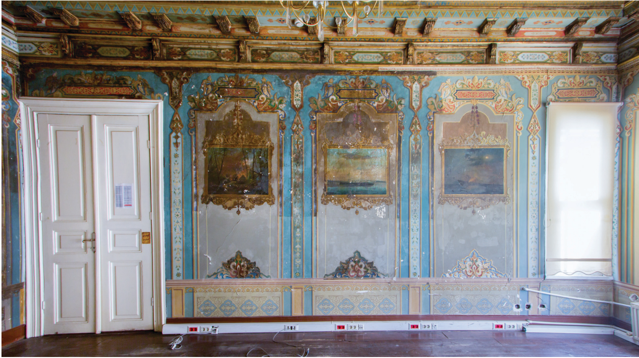
Şekil 26. 104 no.lu odanın duvarlarının konservasyon ve restorasyon öncesi genel görünümü
