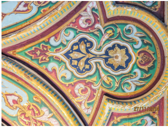
Şekil 37. 104 no.lu odanın tavanının konservasyon ve restorasyon uygulaması sonrası genel görünümü/detay
