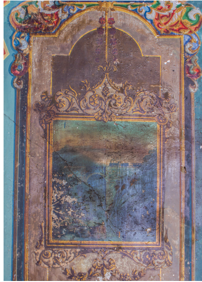
Şekil 10. 104 no.lu odanın D1 cephesi Pano 1
