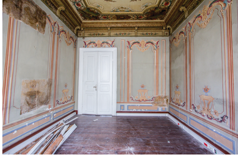
Şekil 25. 102 no.lu odanın duvarlarının konservasyon ve restorasyon öncesi genel görünümü
