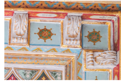
Şekil 39. 104 no.lu odanın ahşap profillerinin konservasyon ve restorasyon uygulaması sonrası genel görünümü
