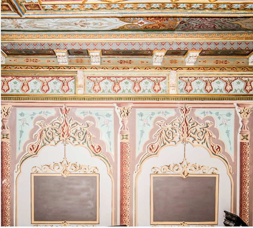
Şekil 51. 108 no.lu odanın D2 cephesi genel görünümü
