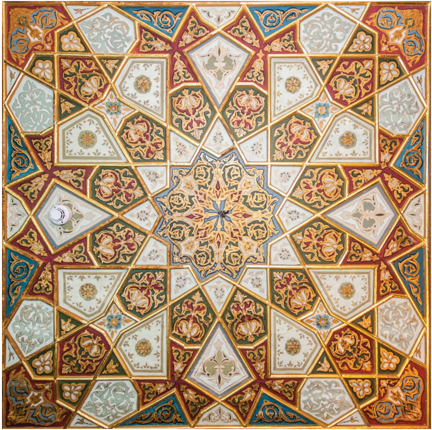
Şekil 46. 108 no.lu odanın tavanının konservasyon ve restorasyon sonrası genel görünümü
