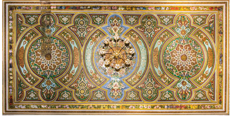
Şekil 36. 104 no.lu odanın tavanının konservasyon ve restorasyon uygulaması sonrası genel görünümü
