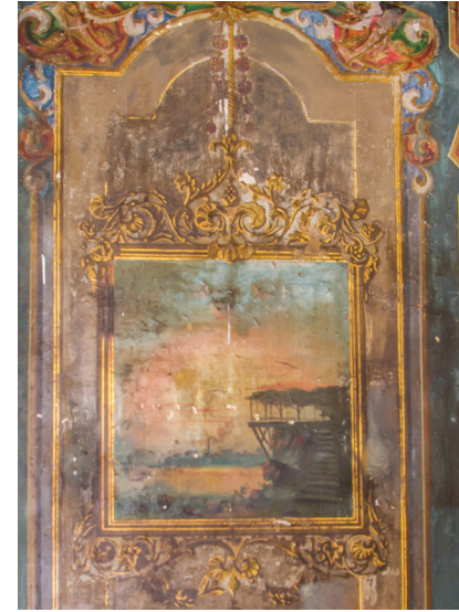
Şekil 11. 104 no.lu odanın D1 cephesi Pano 2
