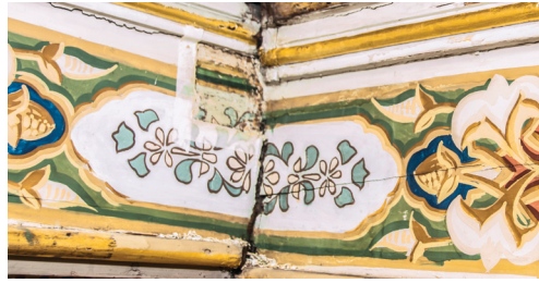
Şekil 38. 104 no.lu odanın ahşap kasetlerinde araştırma raspa uygulaması
