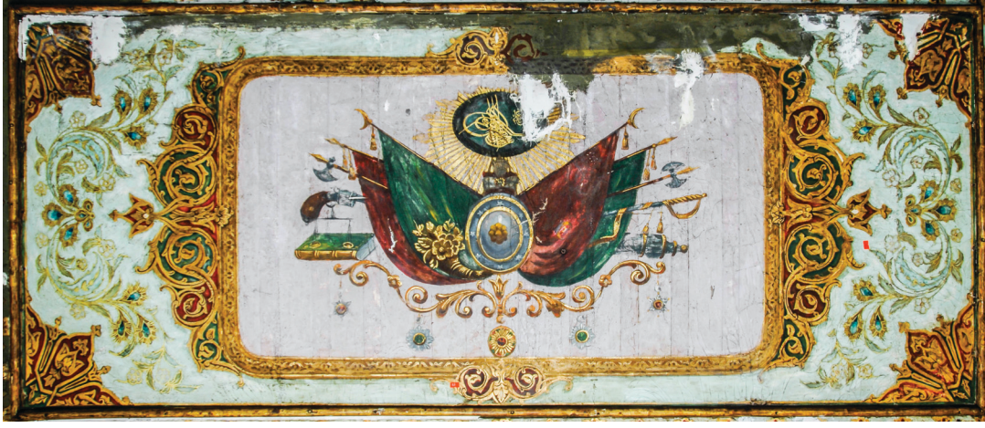
Şekil 47. 108 no.lu oda tavanındaki I. Abdülhamit'e ait Osmanlı armasının konservasyon uygulaması sonrası genel görünümü
