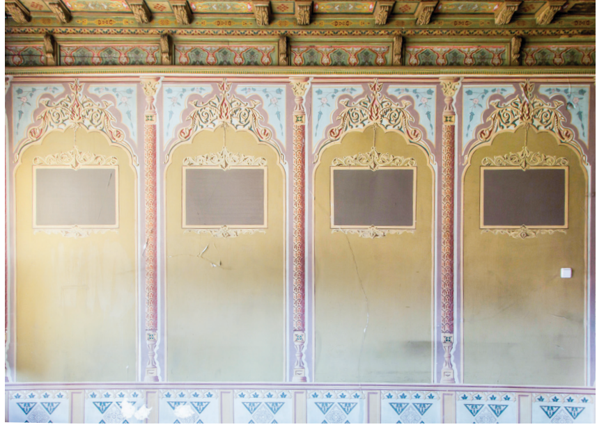
Şekil 29. 108 no.lu odanın D4 cephesi
