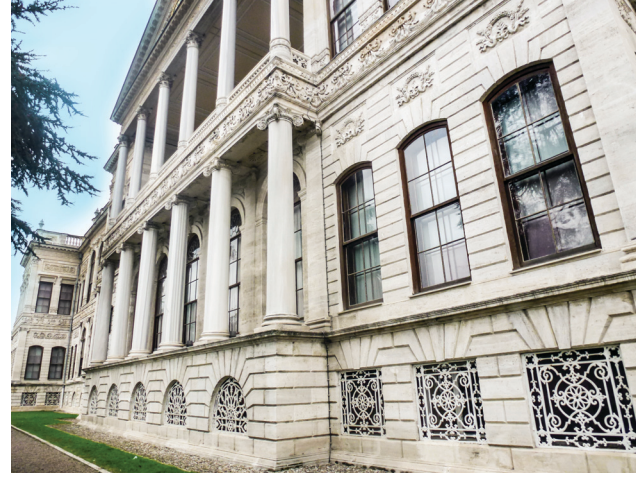
Sekil 4. Mabeyn Dairesi deniz cephesinde Cumhuriyet Dönemi onarımlarında değiştirilen taşlarda küfeki taşından bloklar daha yaygın olarak görülmektedir
