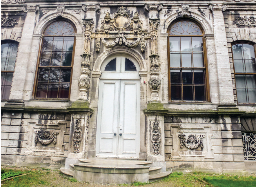
Şekil 12. Mabeyn Dairesi'nin kara tarafındaki binek kapısında mevcut Malta taşları
