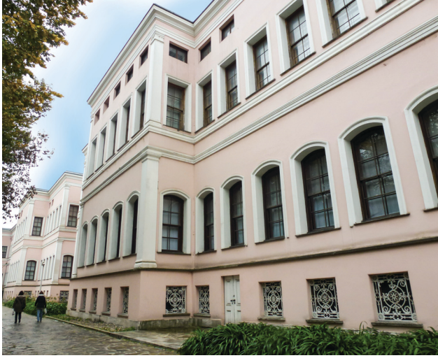
Sekil 3. Sarayın arka cephesindeki sıvalı yüzeyler.
