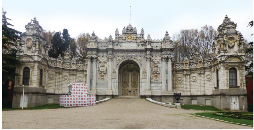
Şekil 10. Dolmabahçe Sarayı Saltanat Kapısı bahçe cephesi.
