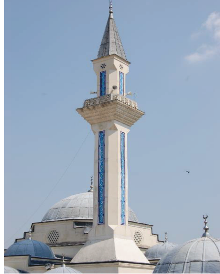
Şekil 12: Bahçeşehir Câmii Minaresi.
