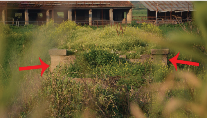
▼ Fot. 6: Hüseyin Ağa Köprüsü, kuzey yakada, yoğun bitki örtüsü ve bataklık oluşumu nedeniyle erişime imkanı bulunamayan kalıntılar. (Şek. 1'de I) (2018, E.Özbay)
