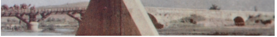
Fot. 9: Demiryolu köprüsünün ayağı ardında Hüseyin Ağa Köprüsü. Mansap. (Fot. 12'den detay.)
