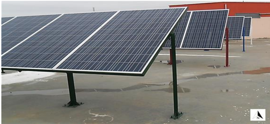
Şekil 3. Fotovoltaiklerin çatıda farklı eęim açlarındaki montajı
