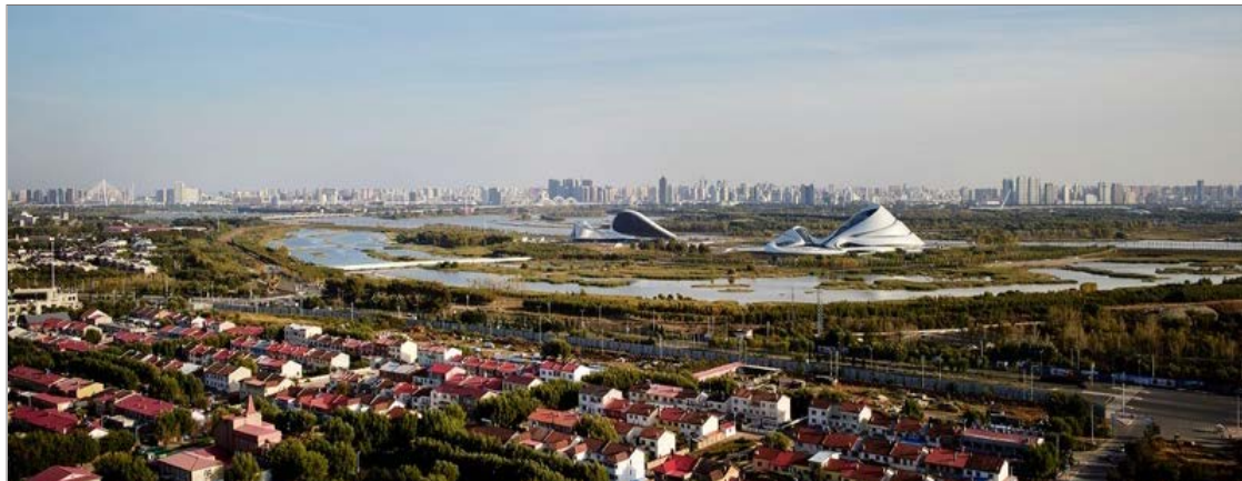
Şekil 7. Kuzeybatı yönünden Harbin Opera Binasına panoramik bakış (URL-11)
