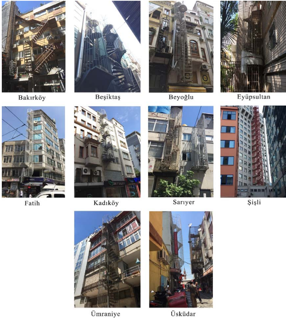
Şekil 1. Alan çalışması yapılan ilçelerden dış kaçış merdiveni örnekleri (External fire escape stairs examples from the districts covered by the field study)
