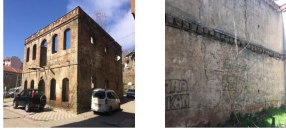
Şekil 1. Tarihi Yığma Bina. (Historical Masonry Building)
