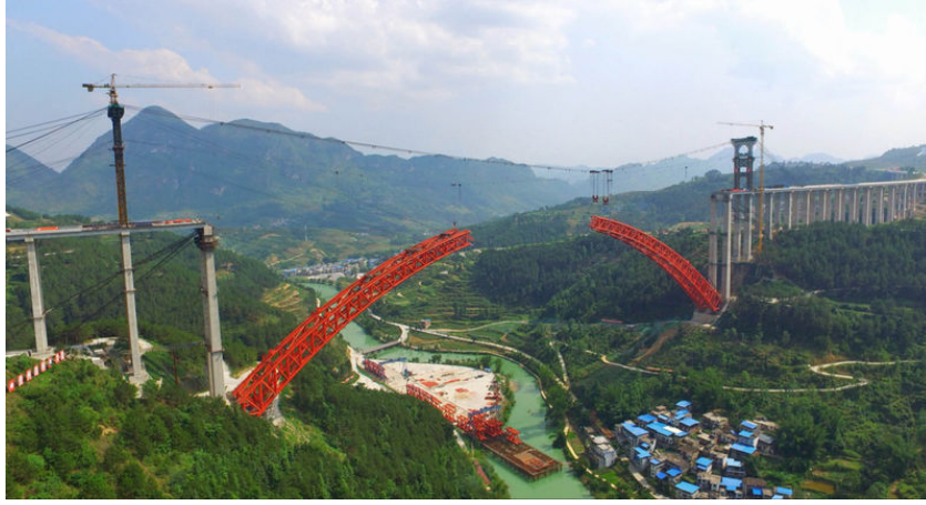
Şekil 3.10. Daxiaojing Köprüsü (Çin) çelik kemerinin konsol uzatımı tekniği ile yapımı [26]
