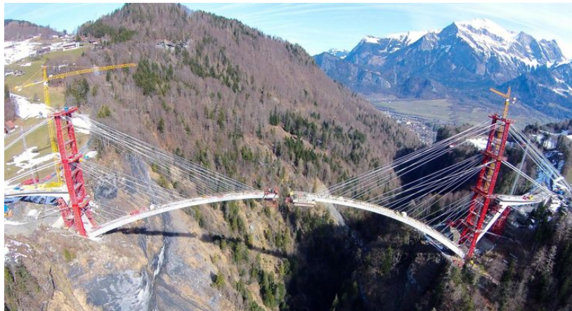
Şekil 3.9. Tamina betonarme kemer köprüsünün (İsviçre) kemerinin konsol uzatımı tekniği kullanılarak tamamlanmak üzere olan hali, [25]
