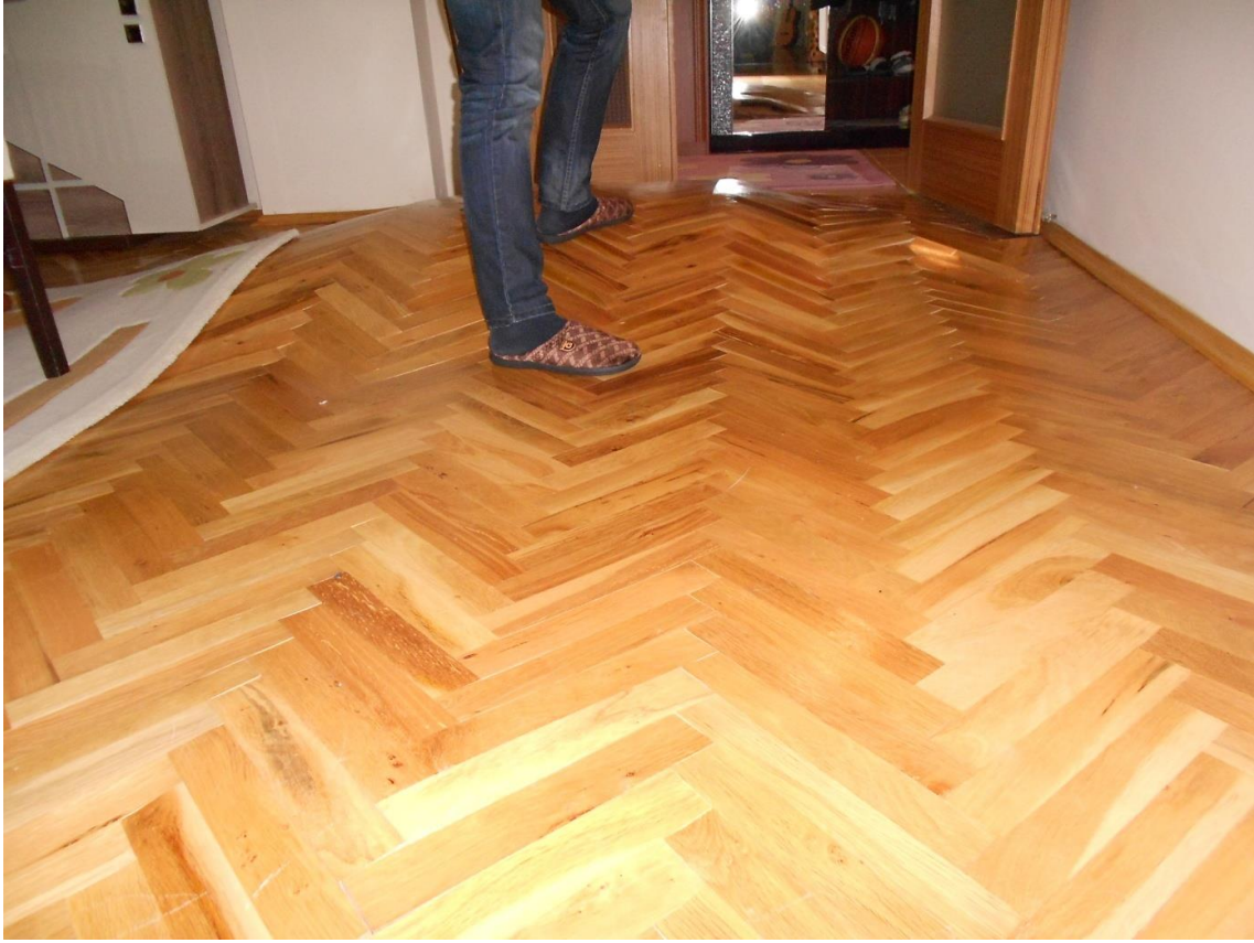
Şekil 19. Salonda ahşap parkenin bir bütün olarak su-nemden etkilenerek kabarma yapması.
