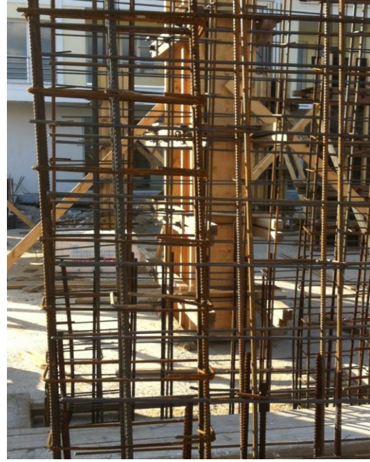
Şekil 4. Betonarme bir yapıda su-nem etkisi ile paslanmış (korozyon) donatıların kolon esas donatısı ve etriye olarak kullanılması.
