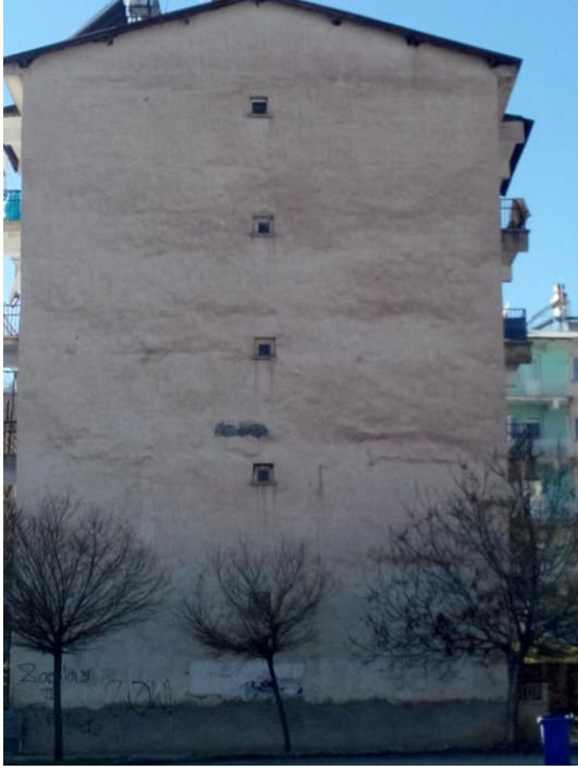
Şekil 14. Yapı dış cephesinde su-nem kaynaklı boyada renk solması sonucu oluşan cephe kirliliği hasarı ve kapiler su emme hasarının özensiz onarımı sonucu oluşan renk farklılığı.
