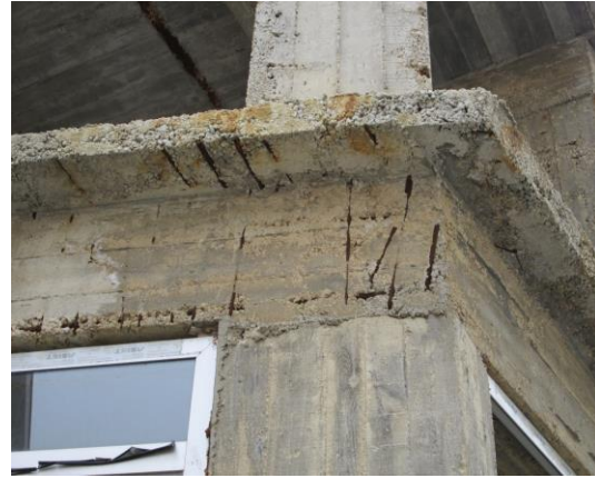
Şekil 4. Betonarme bir yapıda su-nem etkisi ile paslanmış (korozyon) donatıların kolon esas donatısı ve etriye olarak kullanılması.
