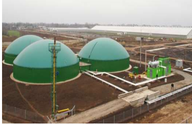
Şekil 6. Biyogaz üretim tesisi
